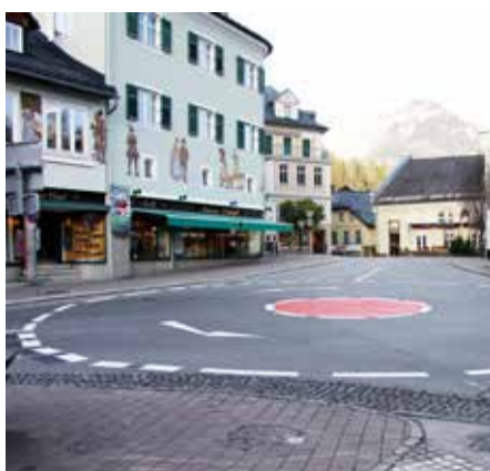
⋮ Der neue Kreisverkehr im Ortskern sorgt für Sicherheit.
