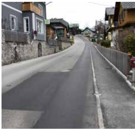
⋮ Gehweg auf der Marktleite zum Schutz der Fußgänger
