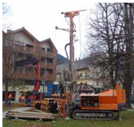
⋮ Neue Frischwasserquelle – Tiefbrunnen – im Kurpark
